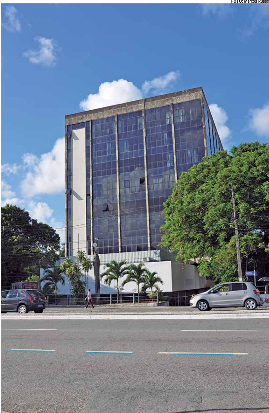
Prédio que foi sede do antigo Paraiban, na Av. Epitácio Pessoa, foi doado pelo Governo do Estado
