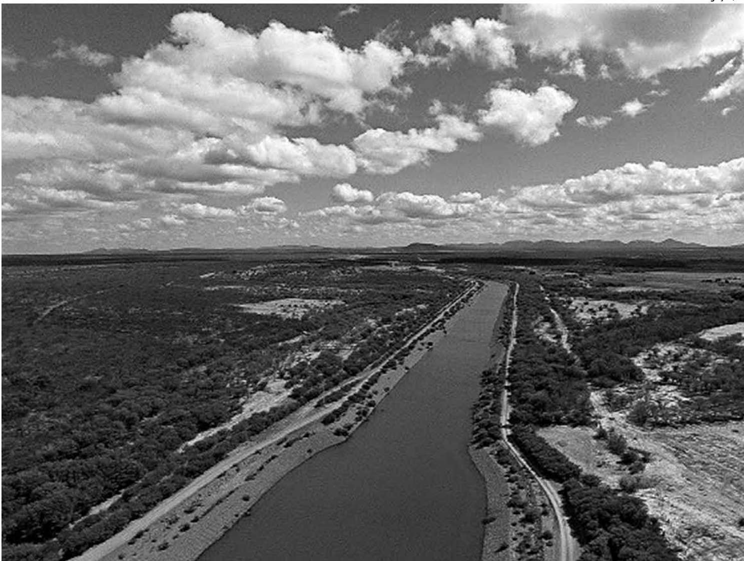
Obras do projeto estarão concluídas entre dezembro de 2016 e o início de 2017, segundo informa o Ministério da Integração Nacional
